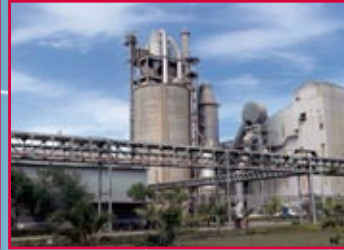
Kompleks Pabrik Tarjun Kotabaru, Kalimantan Selatan Pabrik ke-12
