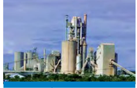
Kompleks Pabrik Tarjun, Kotabaru, Kalimantan Selatan Pabrik ke-12
