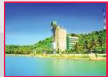
8 Terminal Lembar Lombok Barat, Nusa Tenggara Barat Lembar Terminal West Lombok, West Nusa Tenggara
