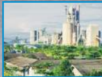
3 Kompleks Pabrik Tarjun Kotabaru, Kalimantan Selatan Tarjun Factory Kotabaru, South Kalimantan
