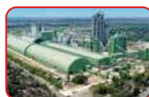
Komplek Pabrik Grobogan, Jawa Tengah Grobogan Factory, Central Java
